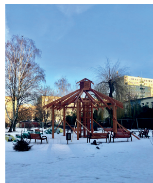
Budowa tężni solankowej na „Niedźwiadku”
